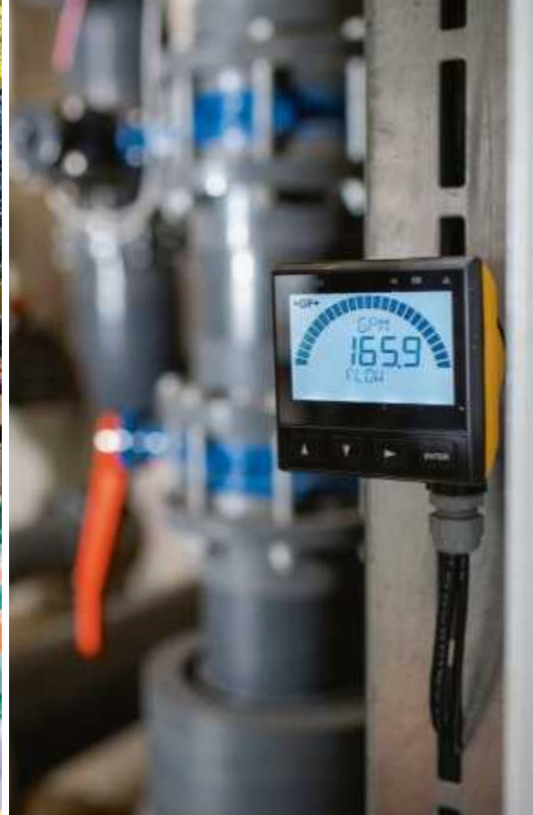
Mit dem GF Signet 9900 Transmitter sind alle relevanten Parameter des Wassers auf einen Blick sichtbar.
